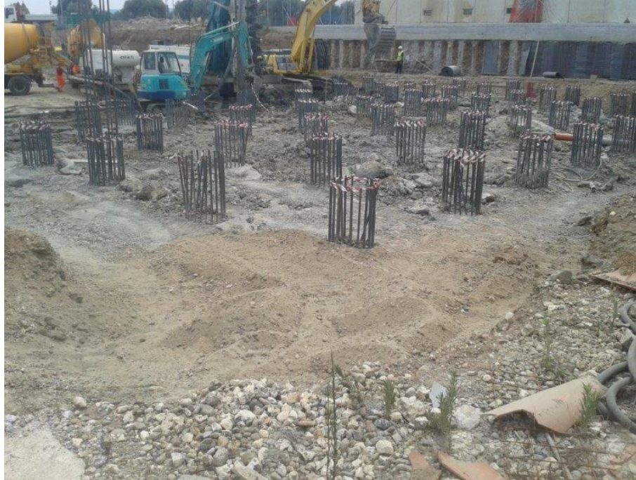
Realizzazione pali di fondazione
