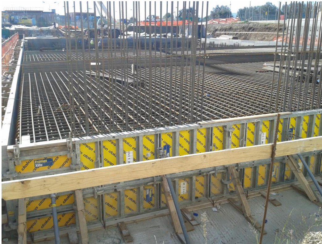
Realizzazione armatura platea di fondazione
